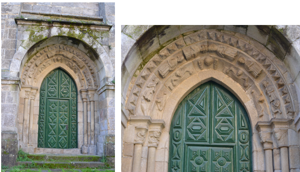
Santa Clara de Pontevedra. Portada septentrional de la iglesia
