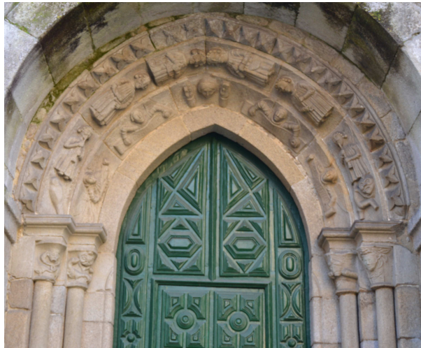
Fig. 10. Santa Clara de Pontevedra. Portada septentrional de la iglesia
